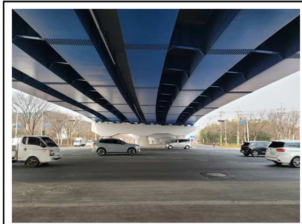
교각 P4 코핑부 상태현황
