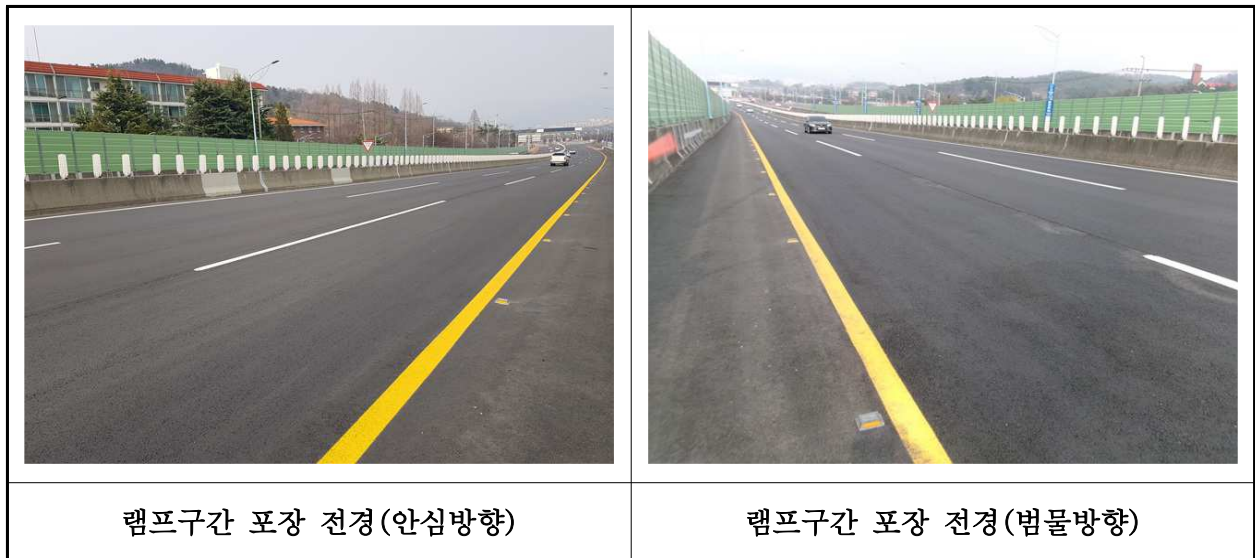
【사진 3.3.28】 램프구간 포장 전경
