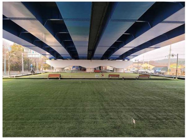
교각 P7 코핑부 상태현황
