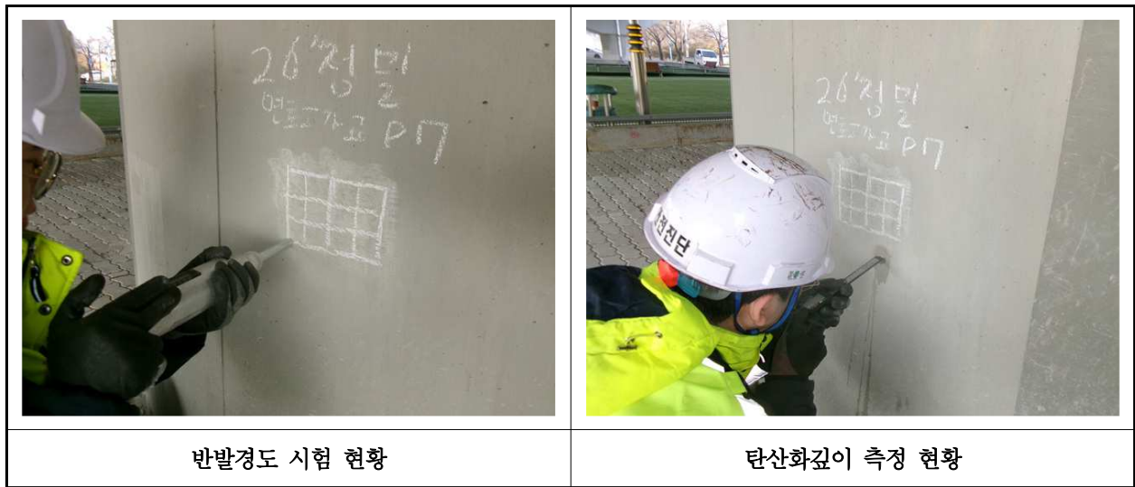
【사진 3.4.1】 콘크리트 내구성조사 현황
