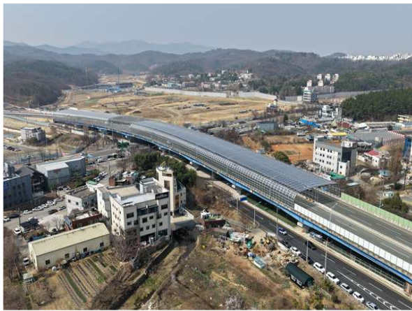
상부 방음터널 전경
