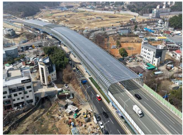
상부 방음터널 전경
