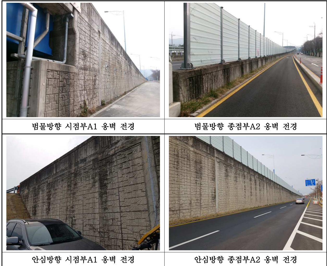
【사진 3.3.30】 램프구간 하부 옹벽 전경
