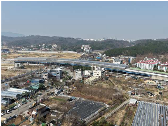
하부 교차 시설 전경
