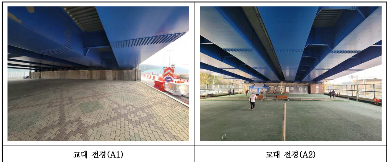
【사진 3.3.8】 교대 전경
