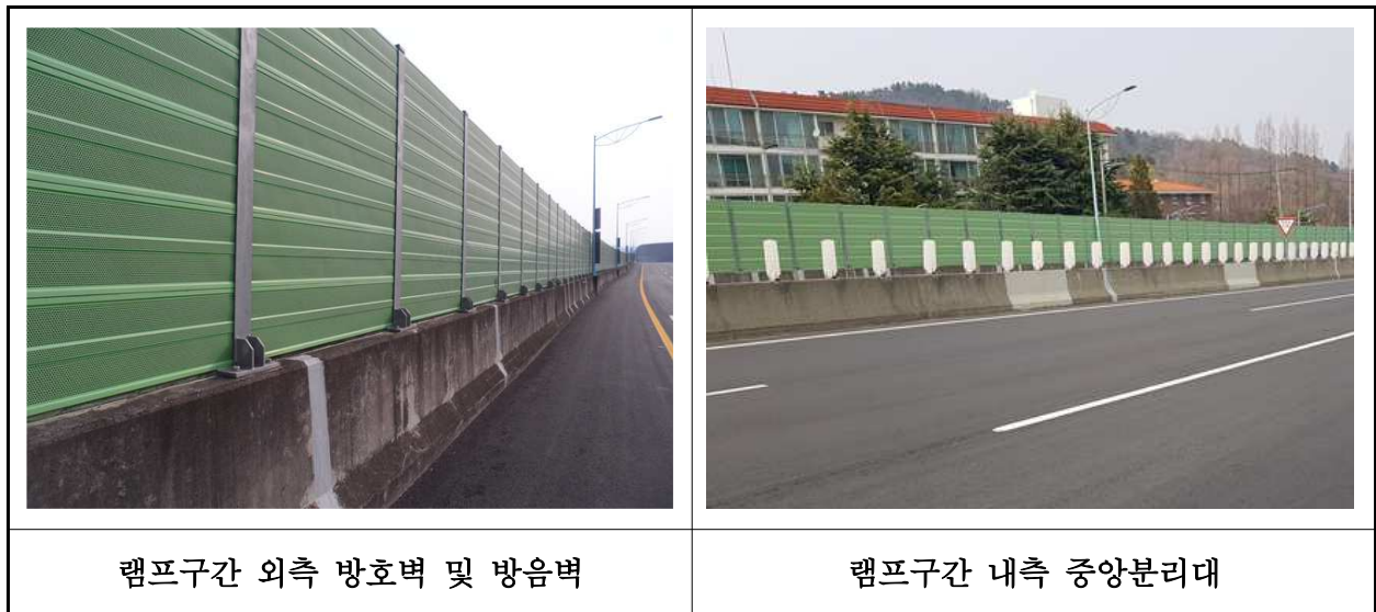
【사진 3.3.30】 램프구간 난간 및 연석 전경
