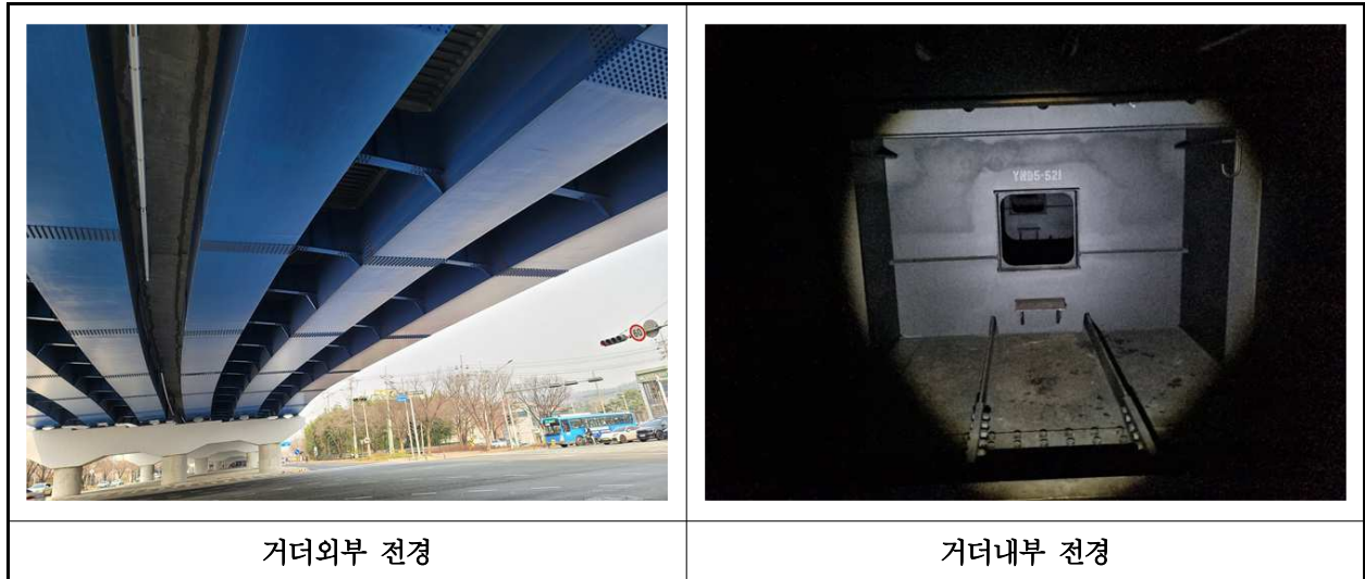
【사진 3.3.4】 거더 전경
