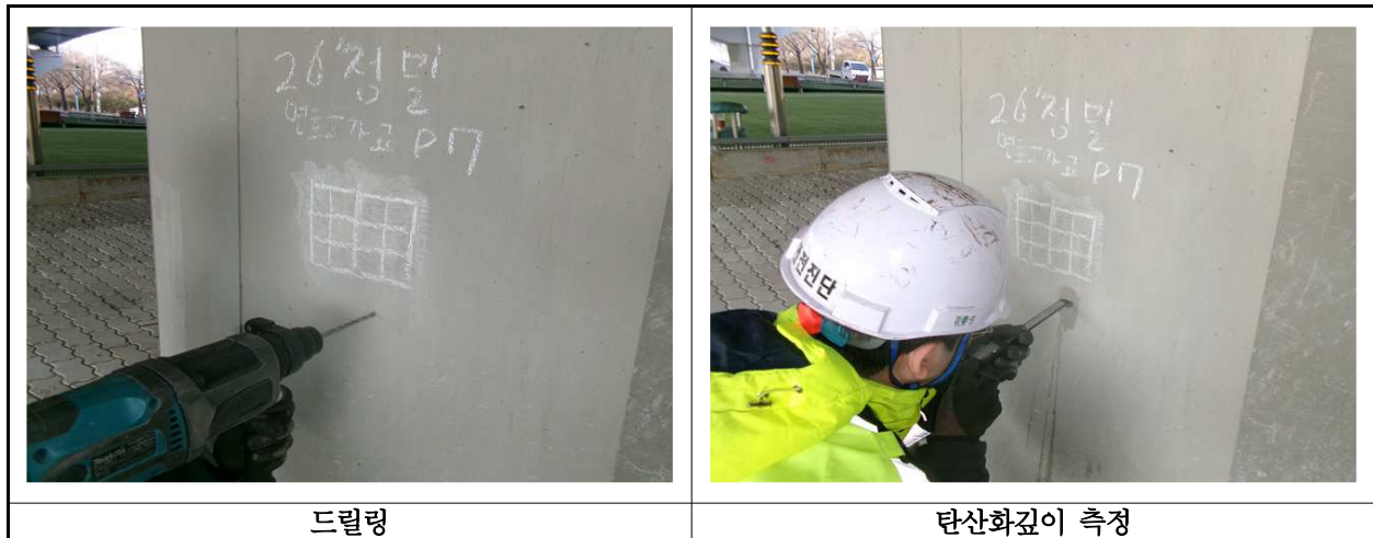
【사진 3.4.3】 탄산화 깊이 측정 현장사진
