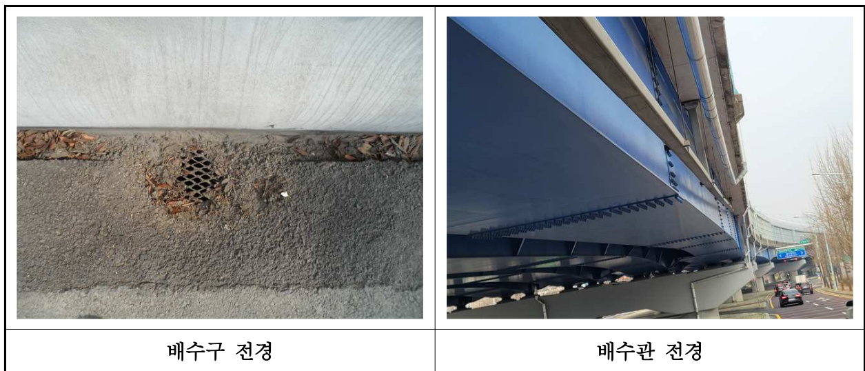
【사진 3.3.22】 배수시설 전경
