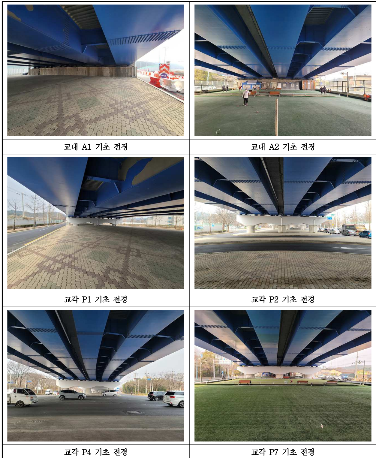
【사진 3.3.12】 기초 전경
